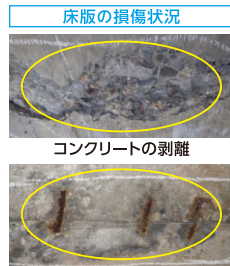
内部鉄筋の露出
