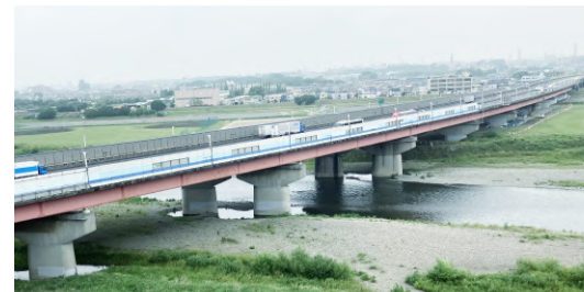
東名多摩川橋
