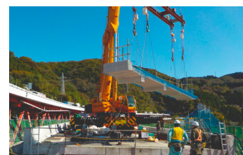
大型クレーンによる全断面床版取替
