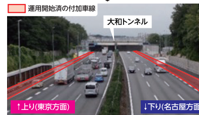
大和トンネル西側区間(上り線)付加車線運用前後
